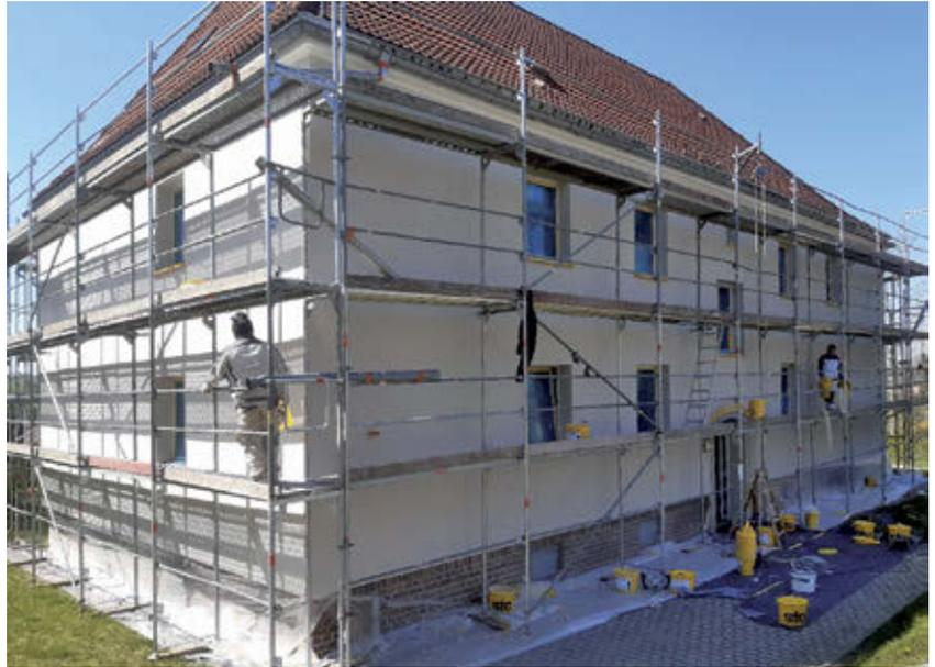
Risse geschlossen und danach der Unterputz aufgetragen. In diesen ist ein Gewebe eingearbeitet. Als Oberputz wählten wir einen farbigen Strukturputz. Komplettiert wurde die Fassade noch durch einen Neuanstrich auf Dachsims und Haustüreffassung.
